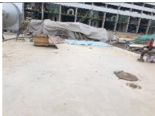
(15) 装置区污水提升池
