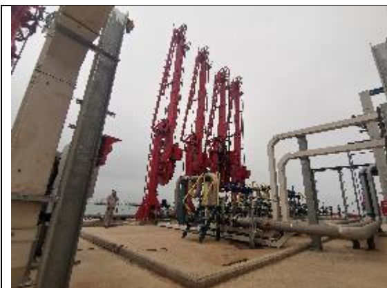
(9) 中科炼化码头区域装卸处围堰
