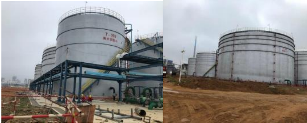
图 2.6-3 中科炼化污水调节罐
