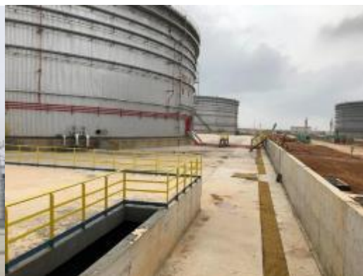
图 2.6-2 中科炼化储罐区的围堰
