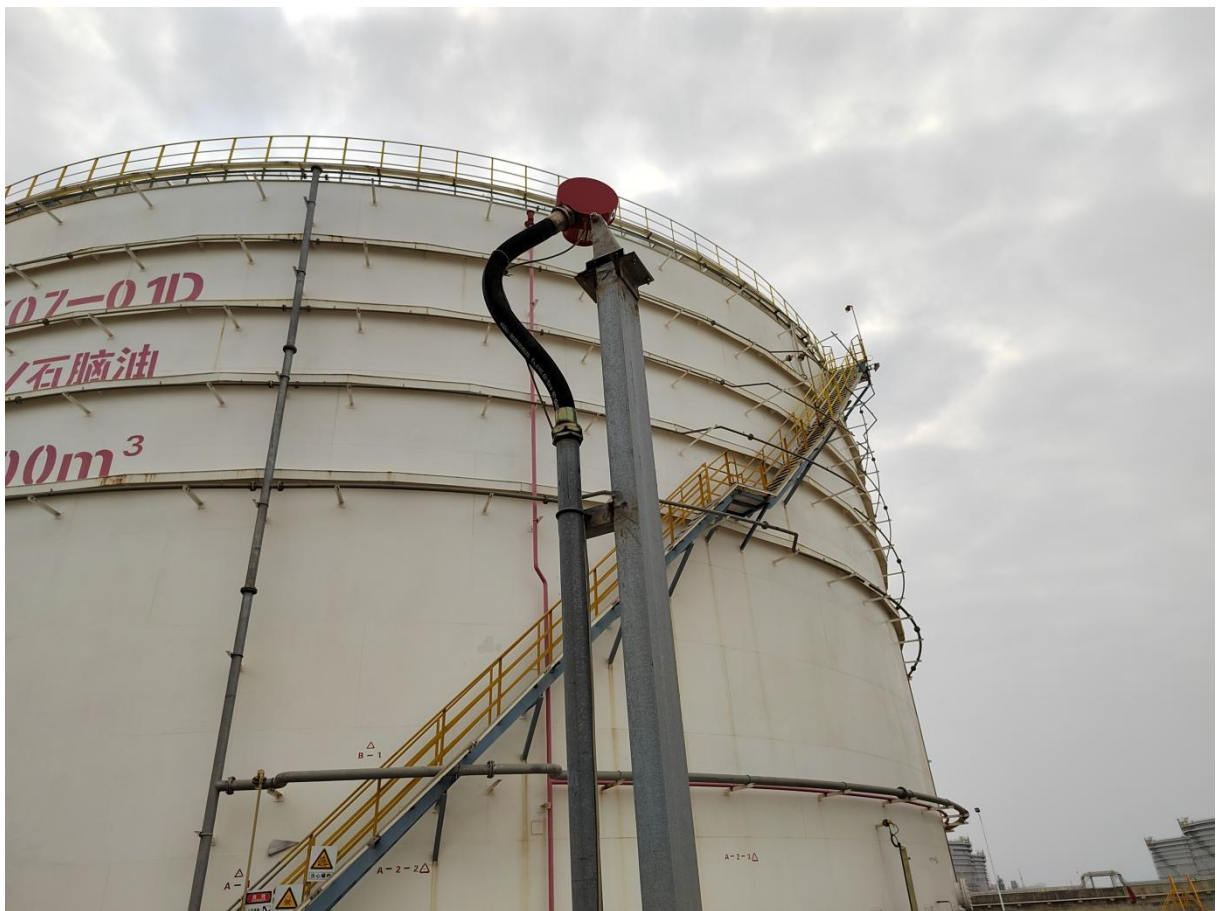
图2.8-4中科炼化火焰探测器示意图
