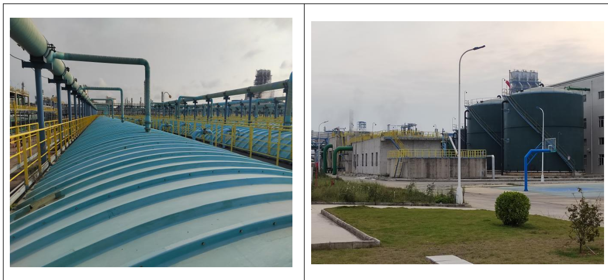
图 2.8-28 中科炼化污水处理场
