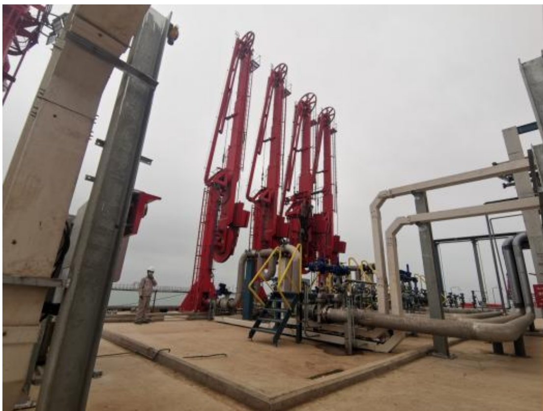
图 2.8-33 中科炼化码头区域装卸处围堰
