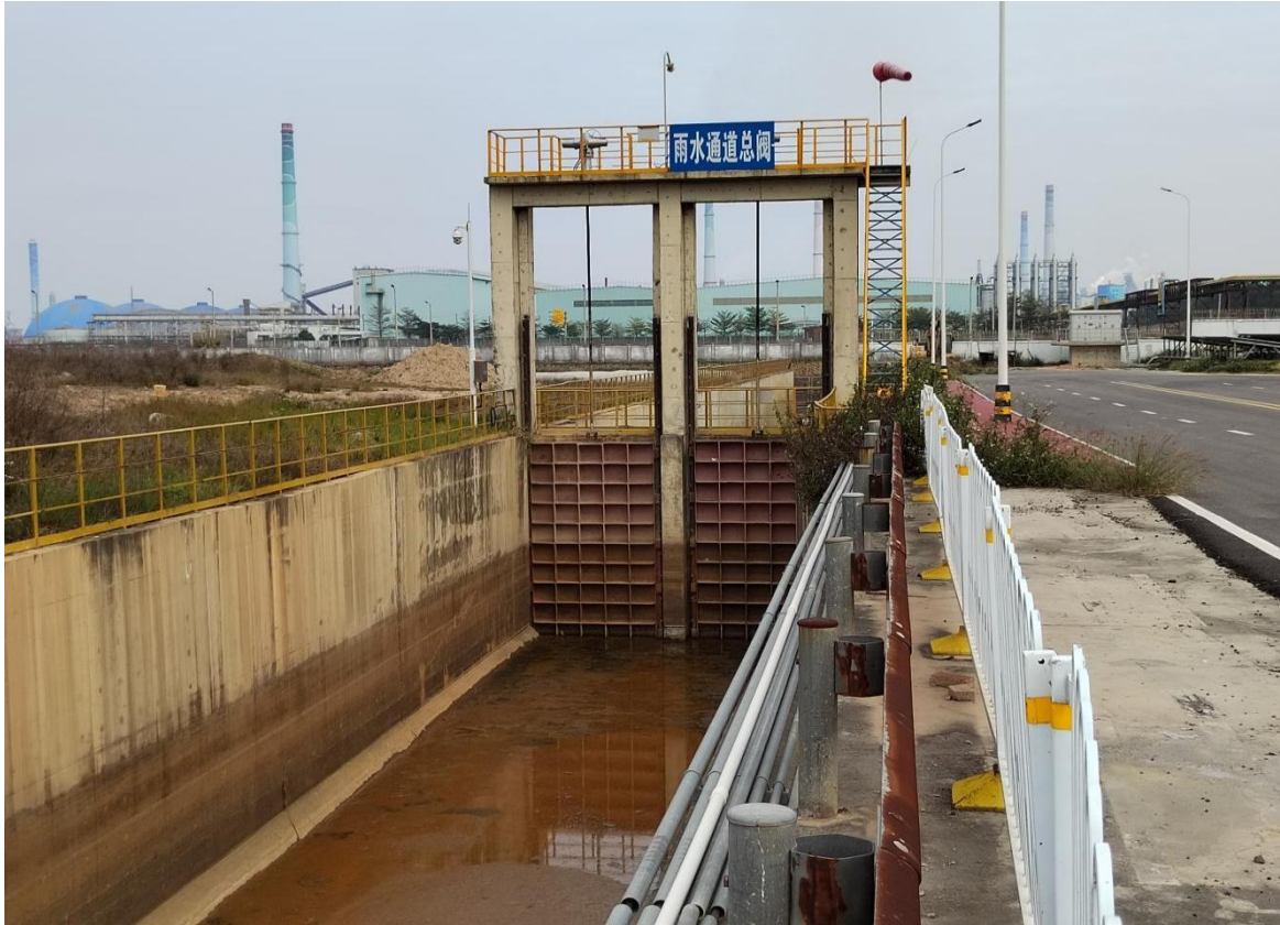
图 2.8-26 北排雨水通道总闸
