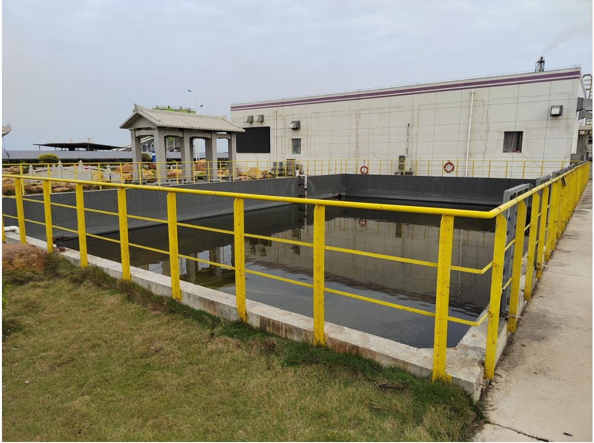
图 2.8-31 中科炼化污水排放口监控池
