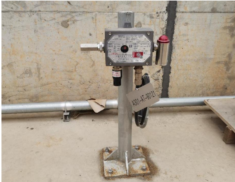
图 4.1-1 中科炼化可燃气体检测仪
