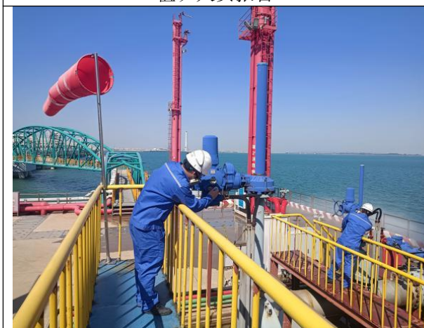
确认阀门关闭、收回输油臂
