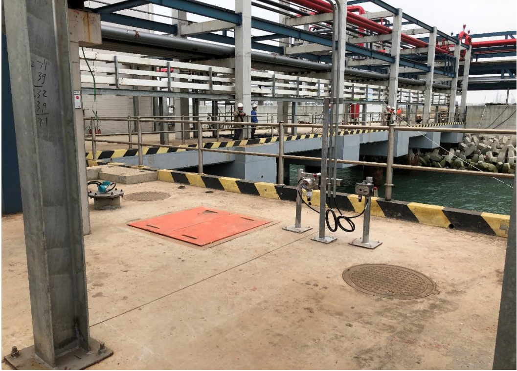
图 2.8-14 码头面的污水坑
