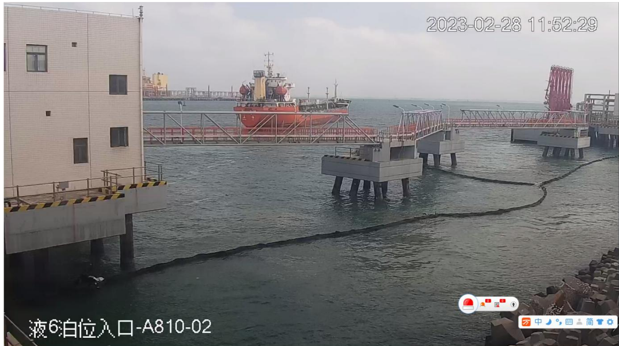
图 2.8-32 中科炼化码头区域围油栏示意图
