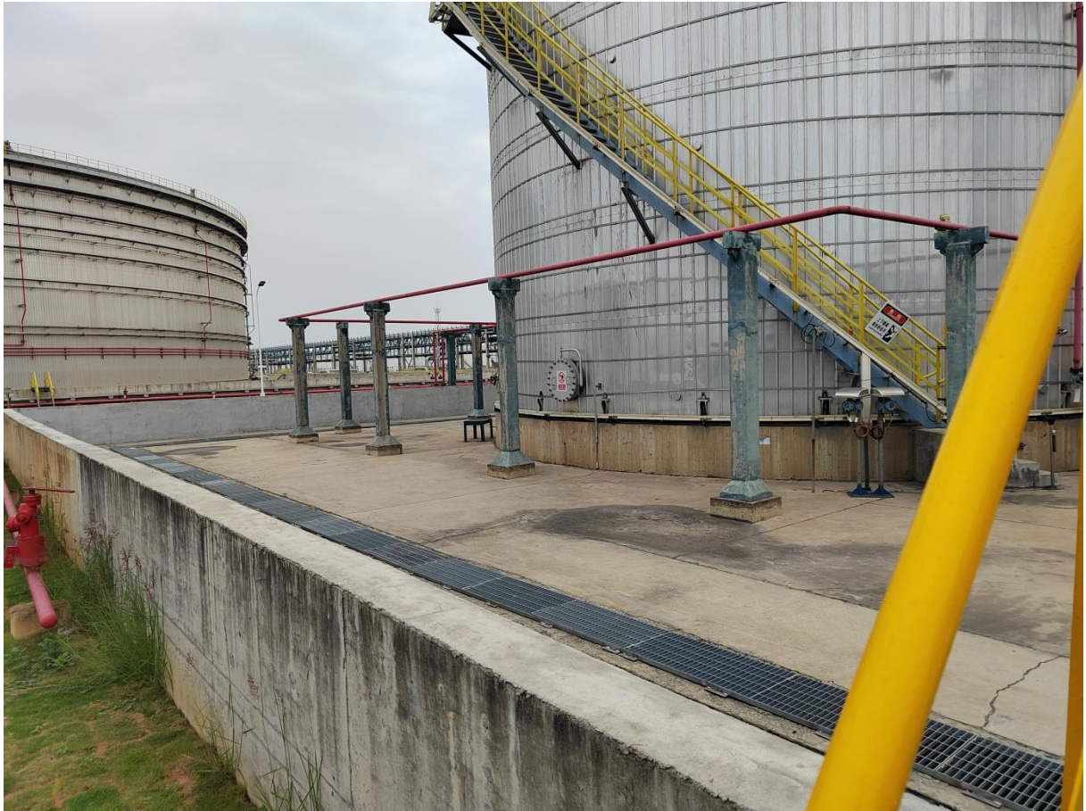
图 2.8-12 中科炼化储罐区的围堰
