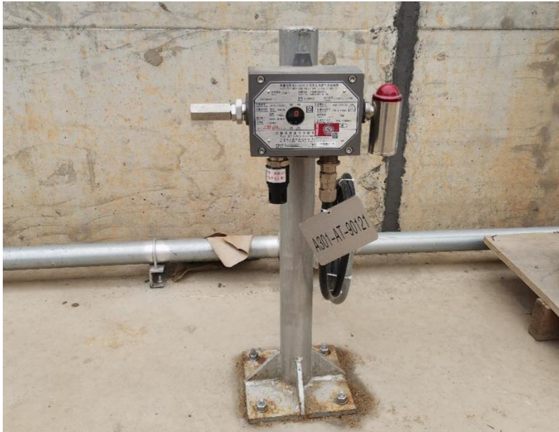
图 2.8-3 中科炼化可燃气体检测仪示意图
