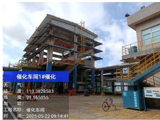
催化车间 50 万吨/年催裂催化装置(1#)
