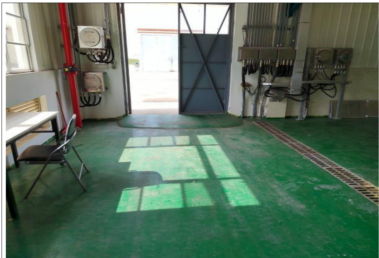
图 4.1-12 危废暂存间缓坡及防渗设置情况
