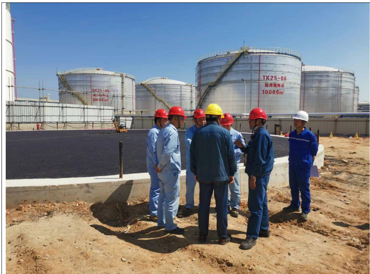
图 4.2-2 防渗工程现场校验图
