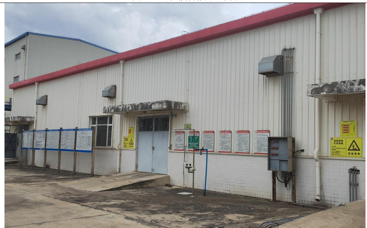
图 4.1-16 危废暂存间侧视图
