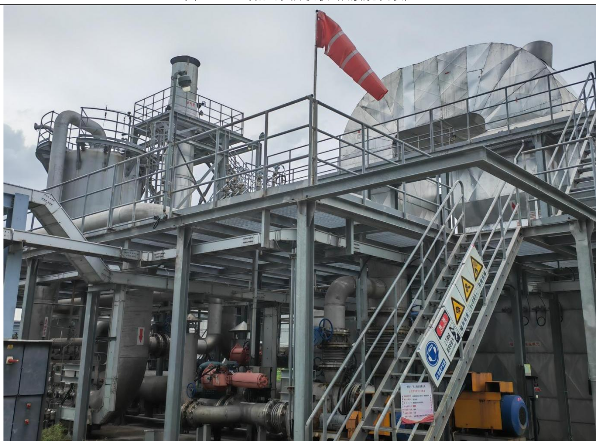
图 4.1-11 脱硫及总烃浓度均化-催化氧化单元
