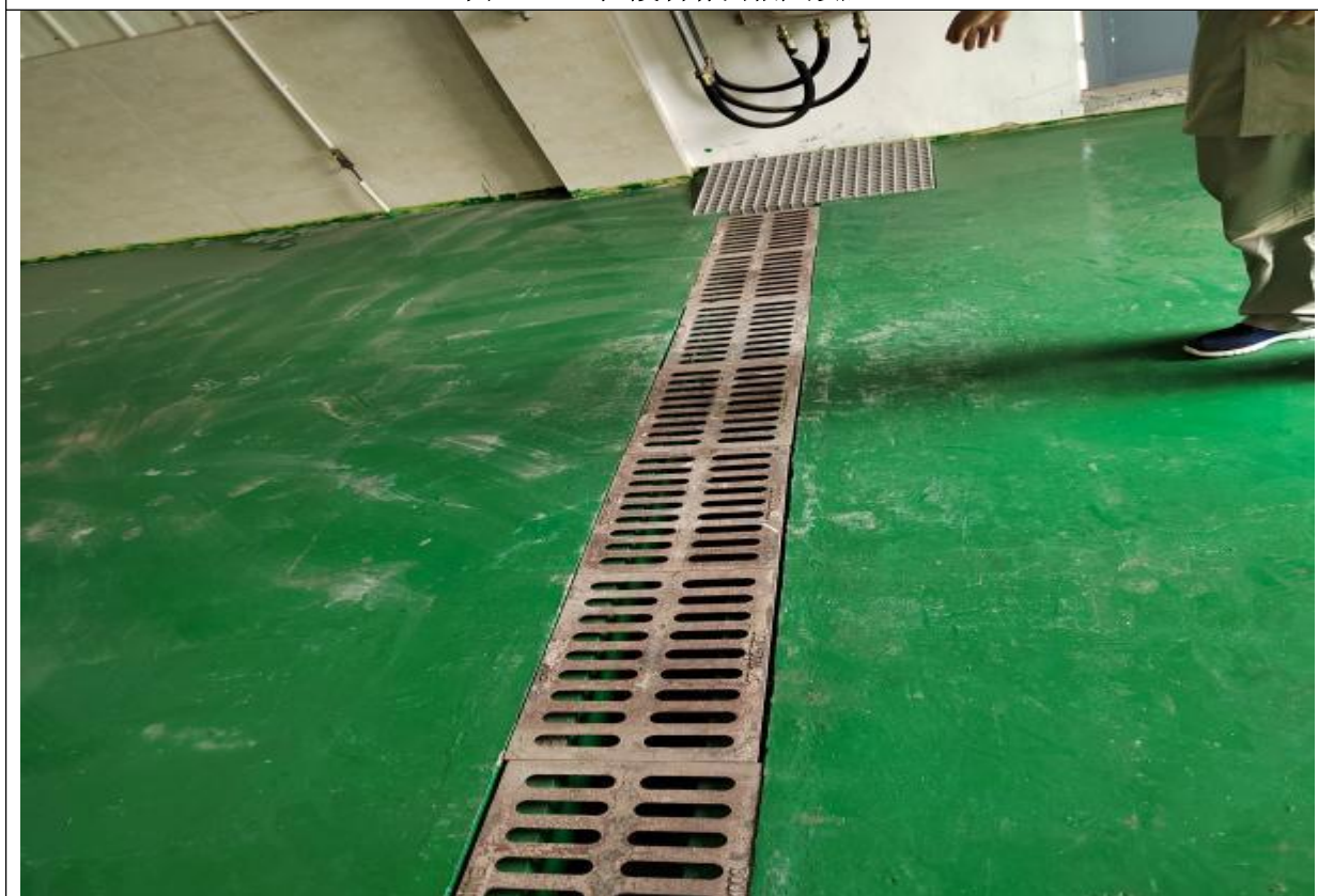
图 4.1-14 危废暂存间导流渠、收集沟设置情况
