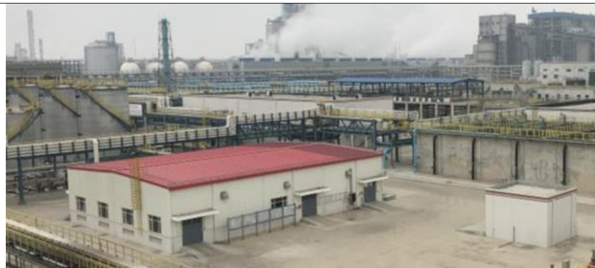
图 4.1-15 危废暂存间全景图
